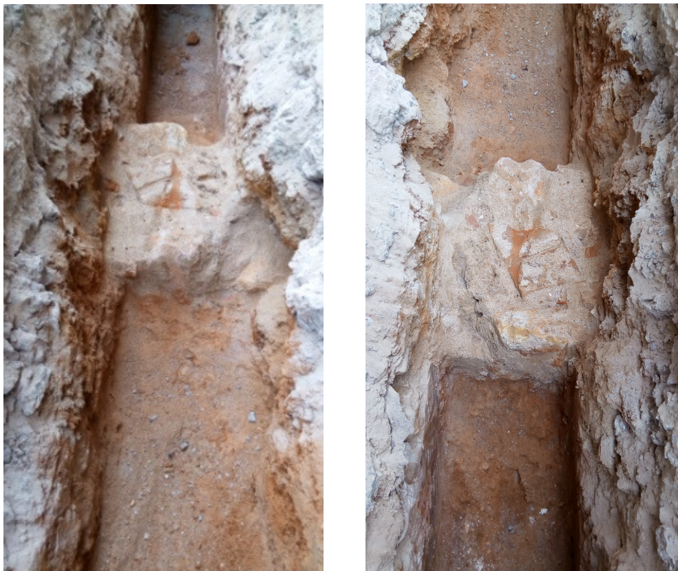
Vista de la fonamentació UE 04.
